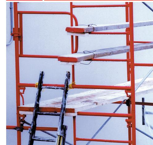
La résistance du plancher doit être nettement supérieure au poids de la charge qu'il supporte.
